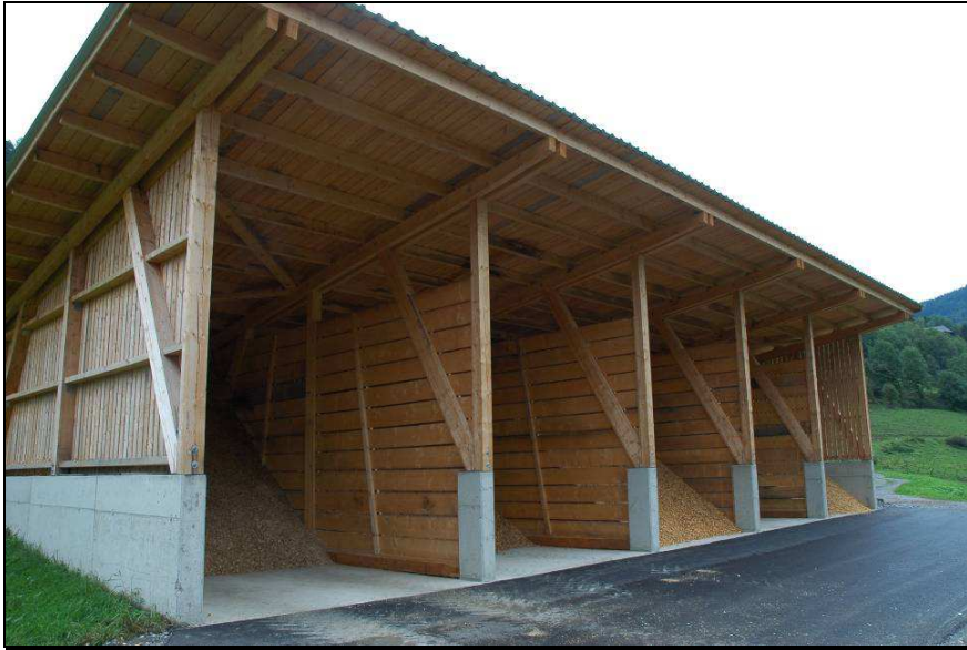
Abb. 2: Einfache Pultdachlagerhalle aus Kanthölzern mit Zwischenwänden in Niederösterreich.
