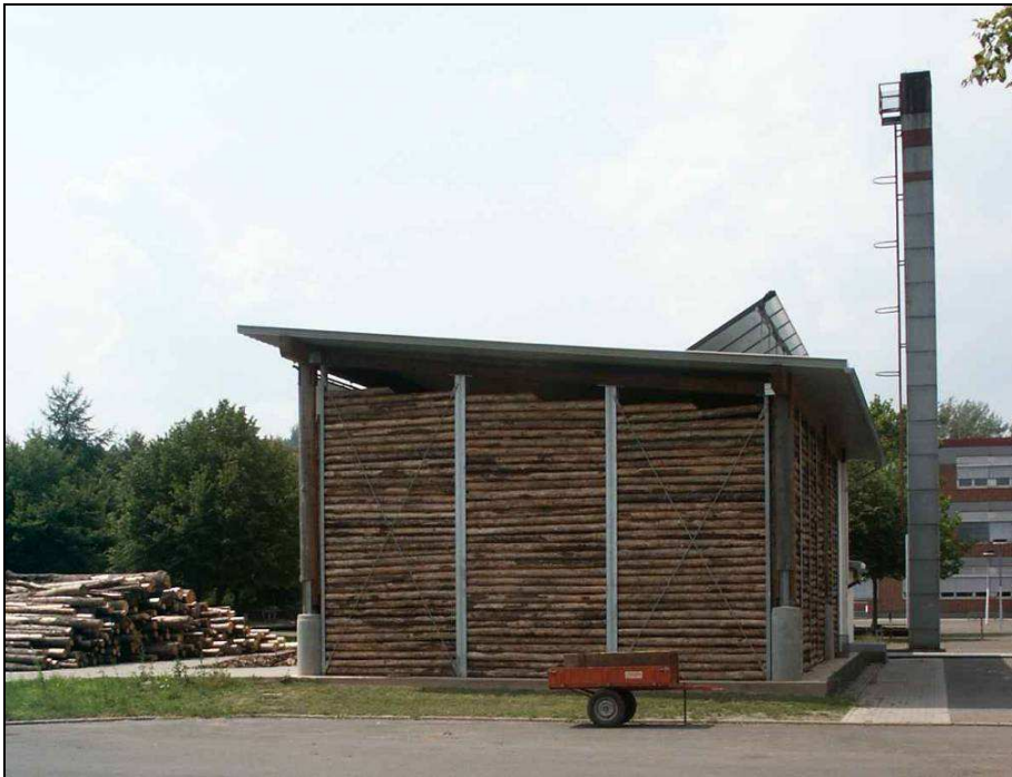
Abb. 3: Einfache und kostengünstige Pultdachlagerhalle mit Rundholzseitenwänden im rheinland-pfälzischen Salmatal. (Foto: Energieatelier Redange)
